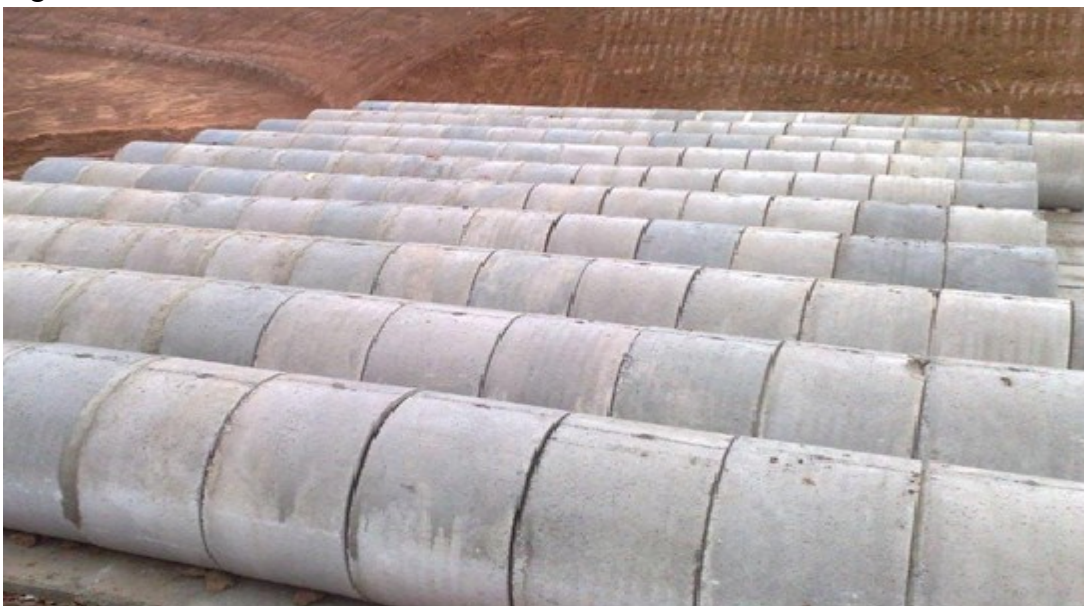
Figura 4: Tubos de 2 metros.
