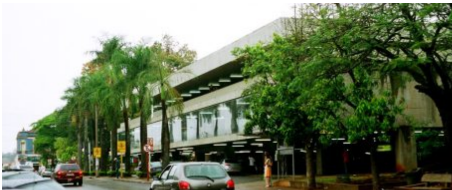
Imagem 15. Acesso nível inferior
