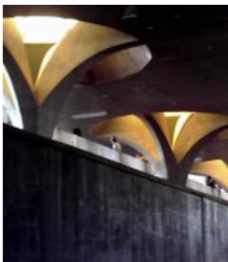
Imagem 19. Abertura dos pilares
