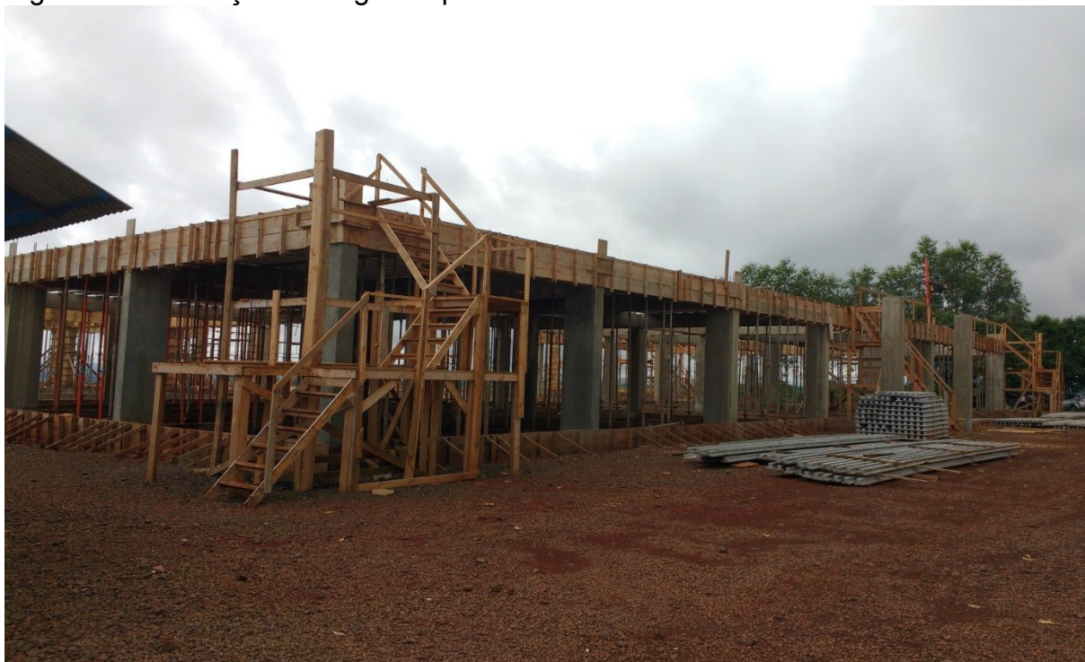
Figura 9- Construção do segundo prédio
