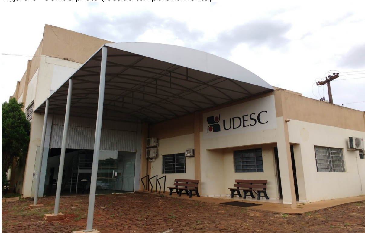
Figura 8- Usinas piloto (locado temporariamente)
