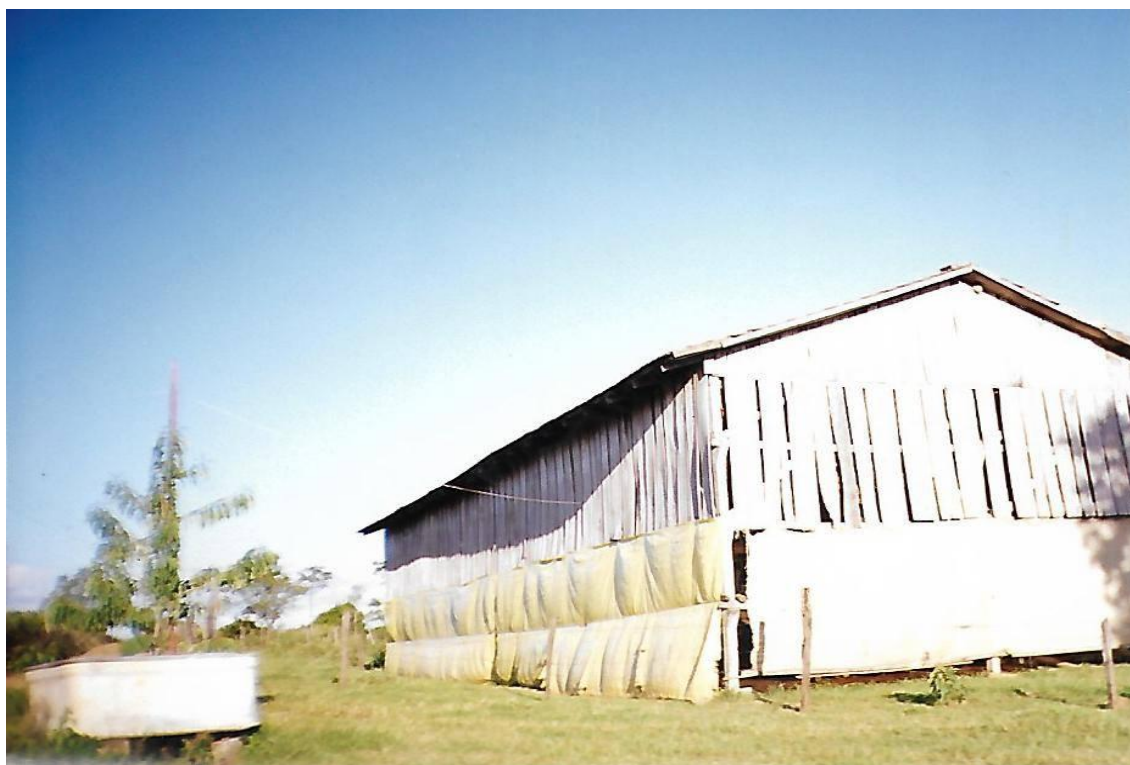
Figura 50: Galpão de armazenamento, separação e organização do fumo na propriedade da Família Manica
