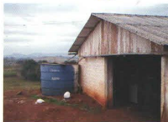
Cisterna armazena água da chuva
