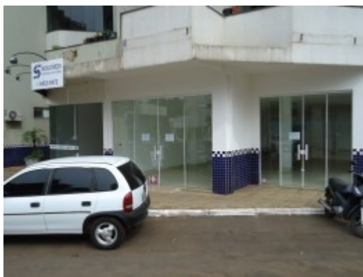
Figura 2 - Vista fachada Externa
