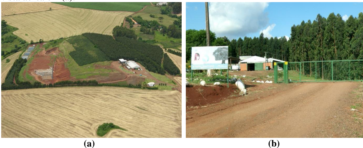
Figura 03 – Vista da entrada do aterro sanitário onde são dispostos os rejeitos em (b) e vista aérea em (a).
