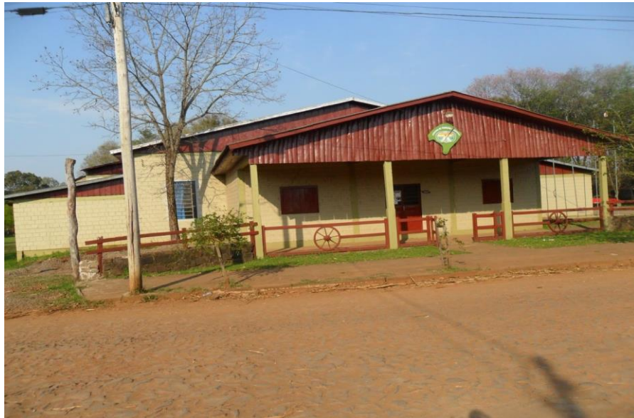
Figura 15: CTG- Corredor Missioneiro
