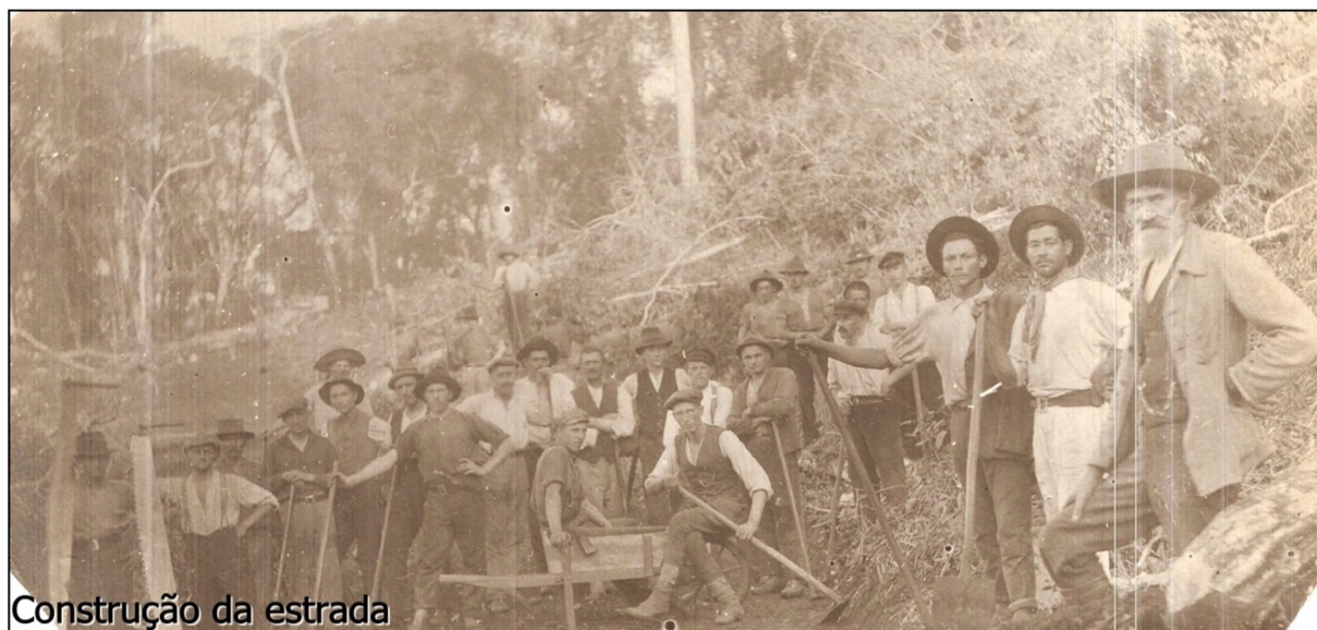
Figura 5 – Trabalhos de construção da “estrada do sertão” [S/A].
