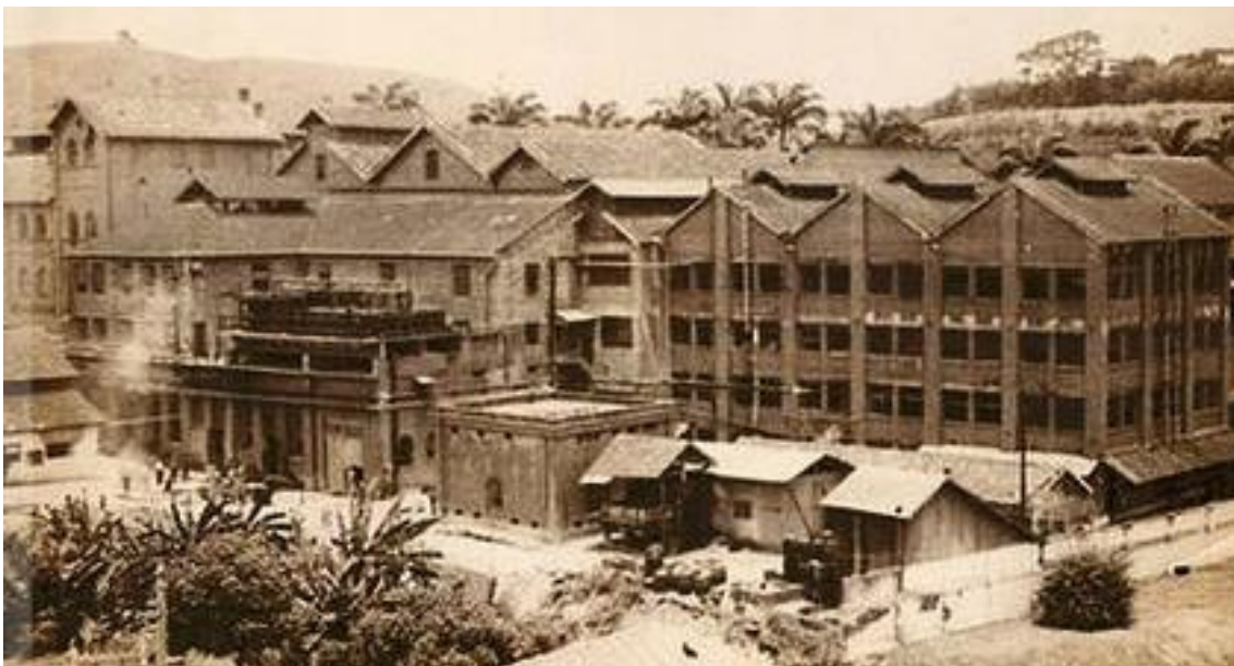
Figura 3 - Frigorífico Anglo do Rio de Janeiro, instalado em 1917
