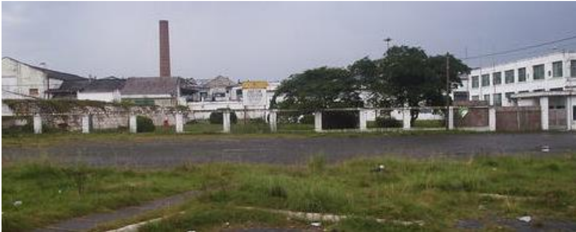
Figura 4 - Frigorífico Armour em Santana do Livramento, RS, instalado em 1917
