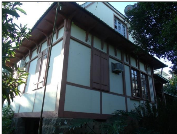
Figura 17 - Casa residencial em enxaimel.
