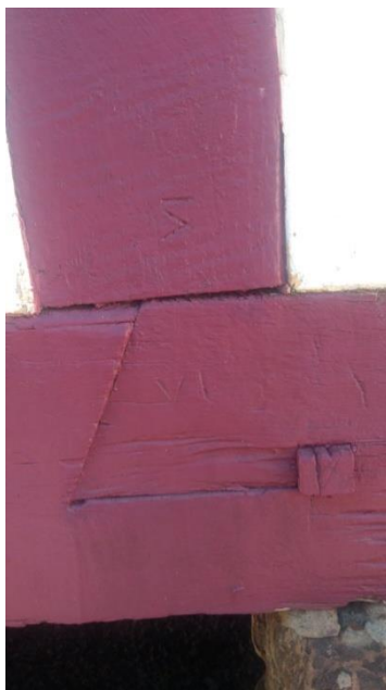
Figura 15 - Marcação na madeira em casa de enxaimel em São Carlos – SC
