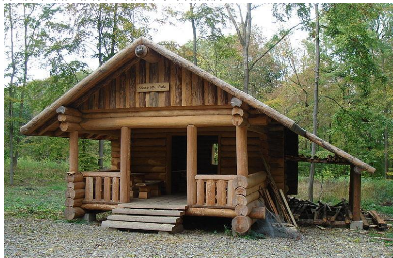
Figura 13 - Casa construída na técnica do blocausse
