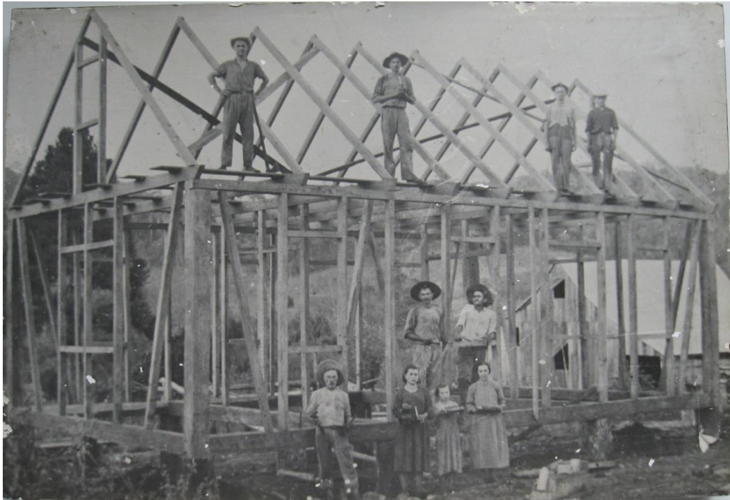
Figura 16 - Estrutura de madeira de uma casa enxaimel em São Carlos -SC
