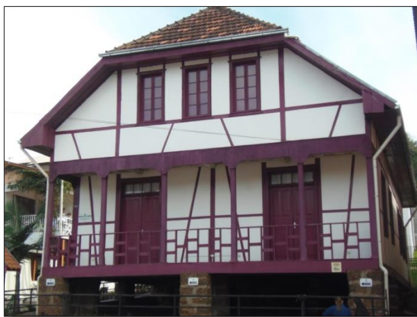
Figura 24 - Edifício público em enxaimel.
