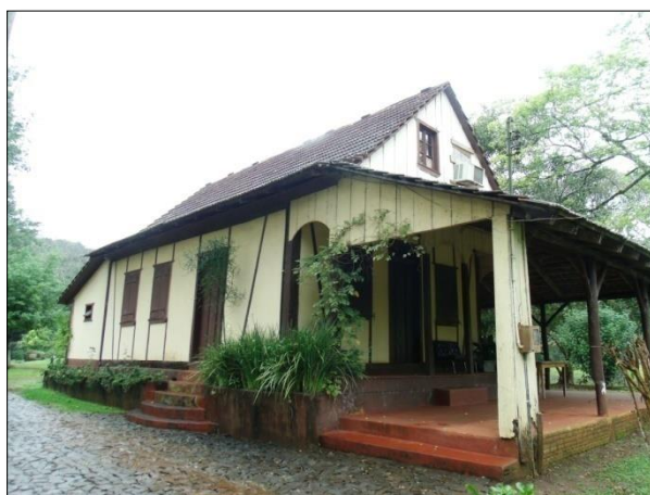
Figura 18 - Casa residencial em enxaimel.
