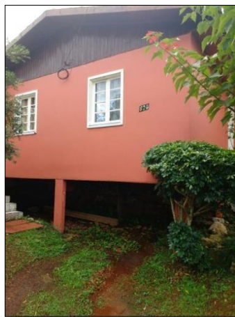
Figura 21 - Casa residencial em enxaimel.
