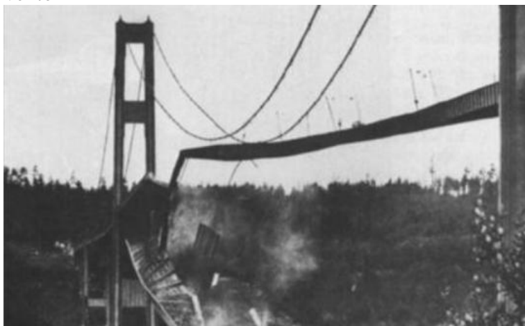
Figura 25 - Ressonância causada na ponte Tacoma Narrows nos EUA, induzida pelo fluxo do vento
