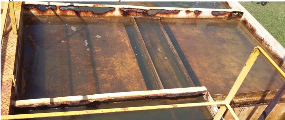
Figura 4 - Unidade de Decantação
