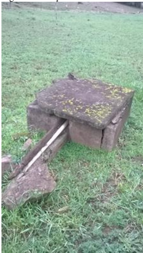
Figura 15 - Poço da Linha Amadeu Sul
