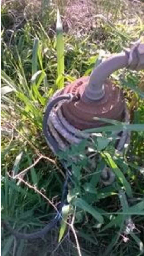
Figura 13 - Poço da Linha Butiá Norte
