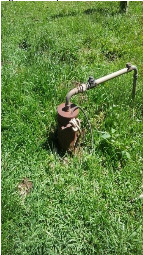
Figura 22 - Poço da Linha Burití
