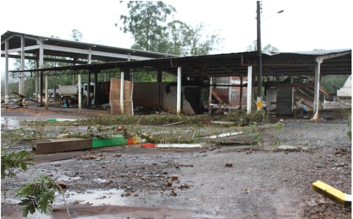
Foto 7 – Departamento Municipal de Estradas e Rodagem (D.M.E.R.).
