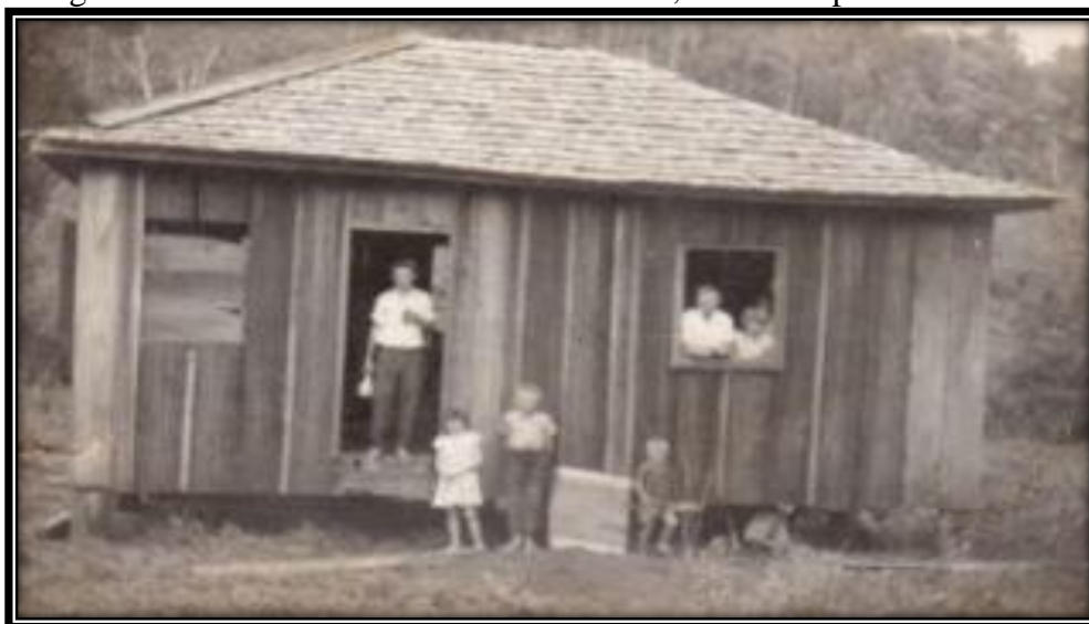
Fotografia 04- Residência do colonizador 1960, no município de Sul Brasil.
