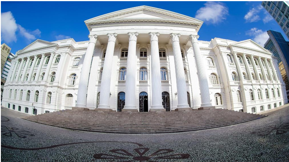
FIGURA 3 - Prédio Histórico da UFPR – Curitiba.
