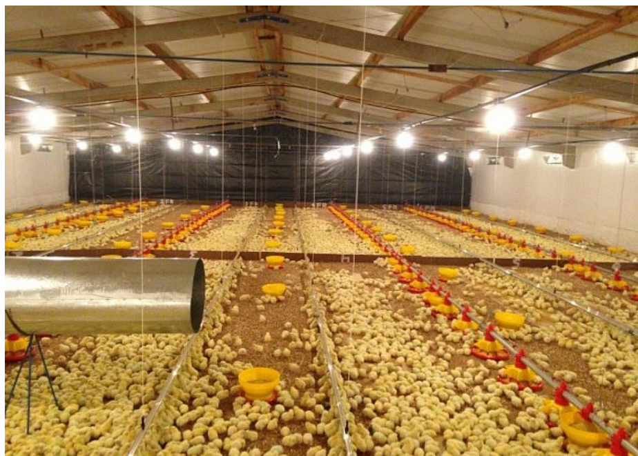
Figura 9- Iluminação de um galpão para aves
