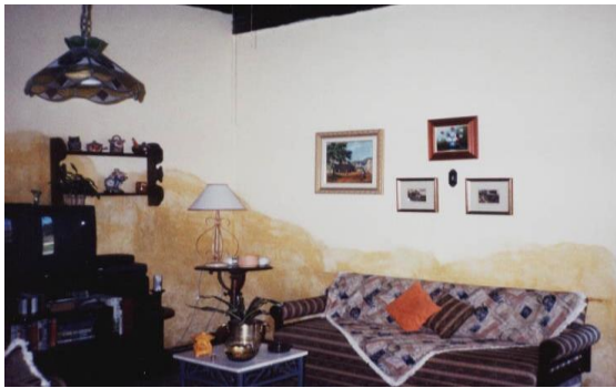
FIGURA 22. - Efeito provocado pela ação da umidade na parede. FONTE – Pesquisa de campo, 2002.
