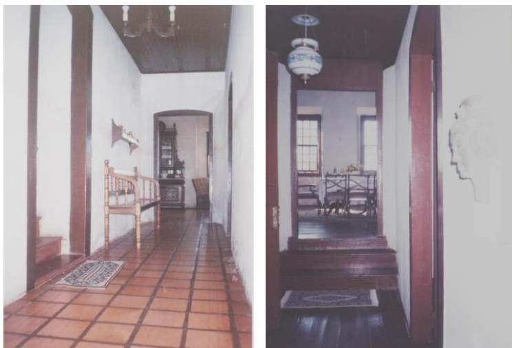
FIGURA 18 e 19 – Circulação no andar térreo e superior, respectivamente. No térreo, à esquerda vê-se a escada que dá acesso ao segundo andar e, ao fundo, as salas de jantar (com as cristaleiras antigas), e de estar (oratório); o piso simples de lajota foi a solução encontrada na época para melhor adequação do local como moradia. No andar superior (à direita), o piso de tábuas de madeira é original; os degraus marcam internamente a transição entre os dois volumes edificados. Ver localização dos ambientes na FIG. 38, do APÊNDICE. FONTE – Pesquisa de campo, 2002.
