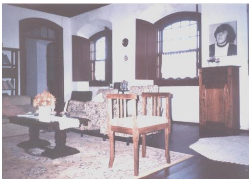
FIGURA 15 e 16 – Ambientes de estar (à esquerda) e jantar (à direita), no andar superior. Janelas do tipo guilhotina, de verga curva e reta, respectivamente, guarnecidas internamente por postigos de madeira. FONTE – Pesquisa de campo, 2002.
