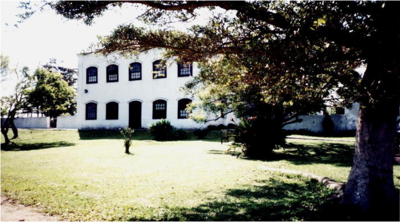
FIGURA 9 – Vista do casarão antigo da Fazenda do Sobrado FONTE – Pesquisa de campo, 2002.
