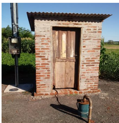
Figura 3- Poço Esquina Laranjeira.
