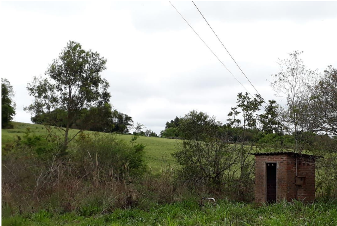
Figura 12 - Poço de captação de água subterrânea localizado próximo a área agrícola, comunidade da linha Caçador.
