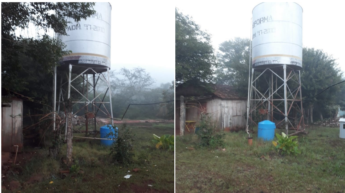
Figura 21 - Poço de captação de água subterrânea localizado na comunidade da Vila São Jorge.
