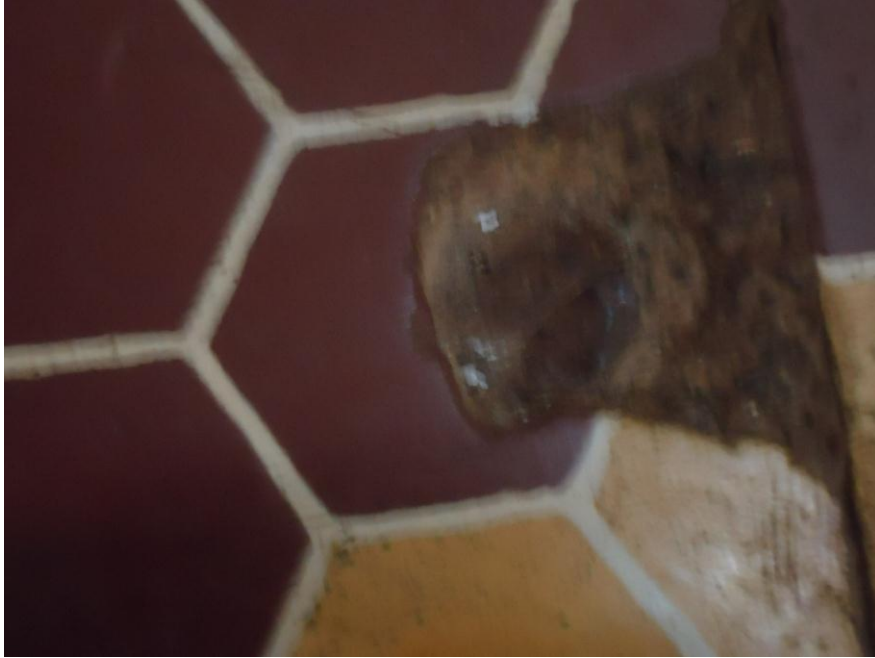
Figura 9 – Imagem do chão do então Hospital Psiquiátrico localizado no Centro Espírita
