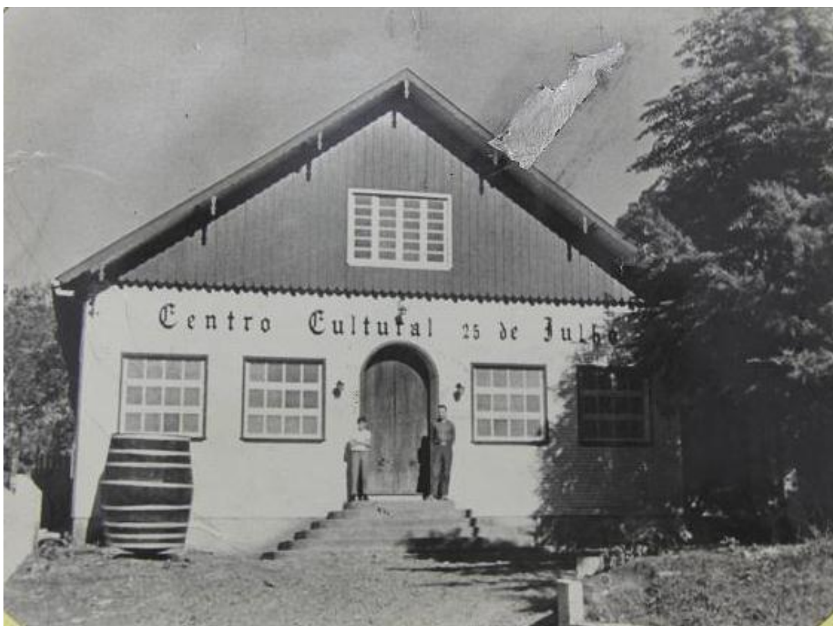
Figura 13 Prédio antigo do Centro Cultural 25 de Julho. 1955. Álbum Fotográfico da História de Erechim, 1999.
