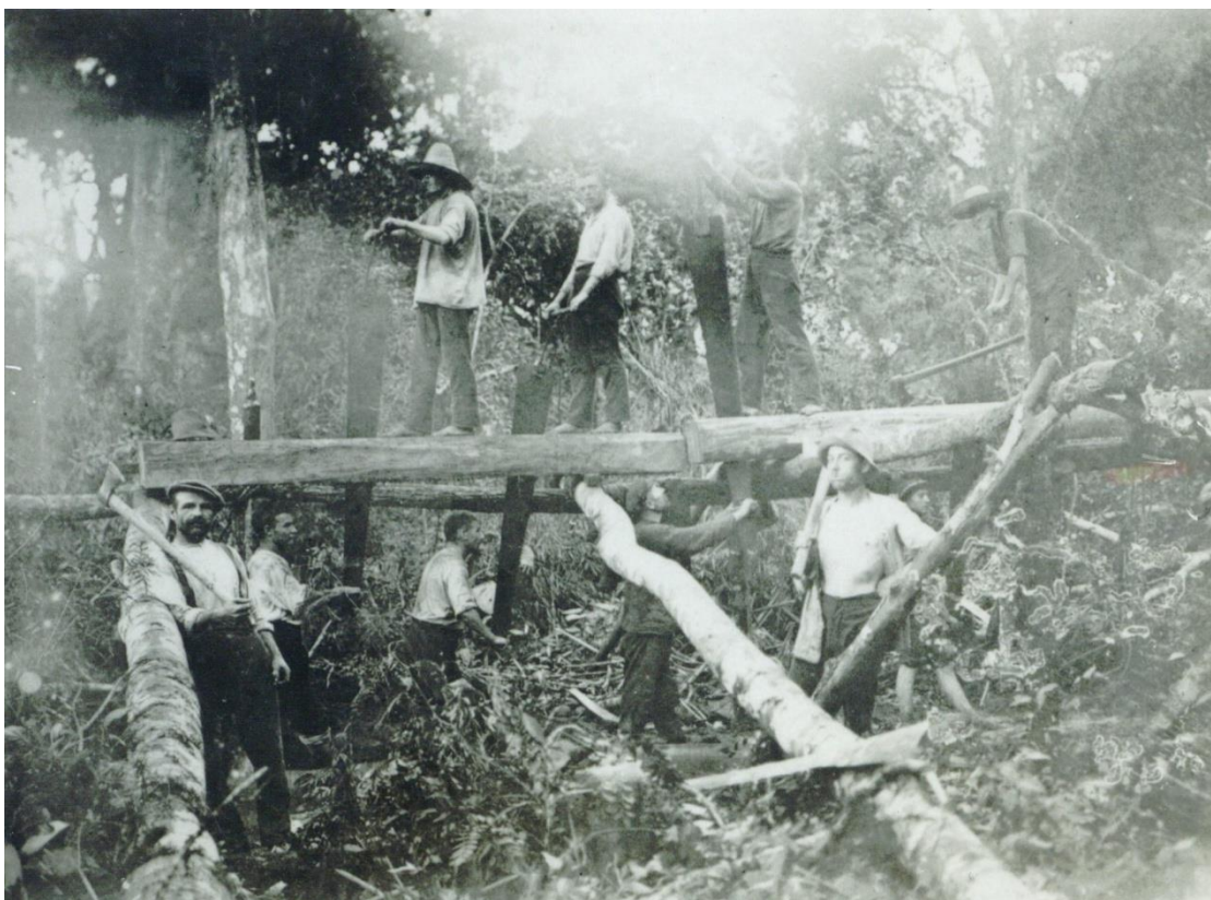
Figura 12. Grupo de colonos em meio a mata no corte e desdobre da madeira com método manual Década de 1930, em Chapecó SC Fonte: Acervo CEOM/Unochapecó.
