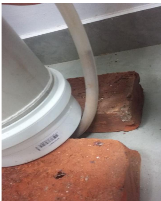
Figura 19 - Tampa de PVC já fixada no tubo.
