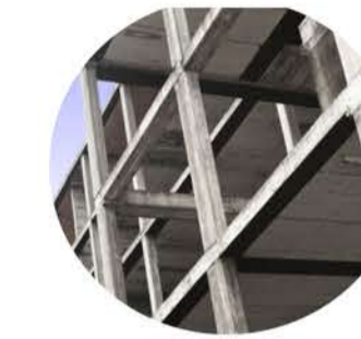
Estrutura em concreto
