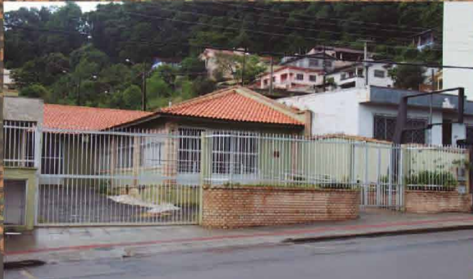
Figura 12: Atual Casa do Produtor Rural, espaço pequeno que não atende as demandas do município. Fonte: Prefeitura de Concórdia
