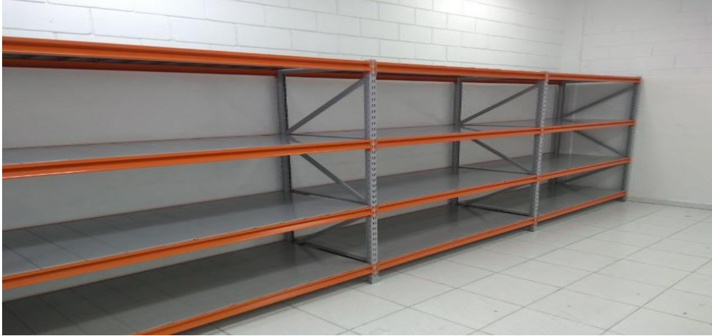
Figura 19 - Prateleiras para armazenamento de peças.
