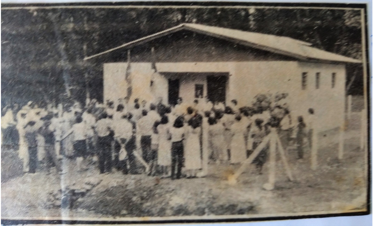
Figura 17: Escola da comunidade Linha Três Município, posterior a derrubada da Brizoleta. (s.d).
