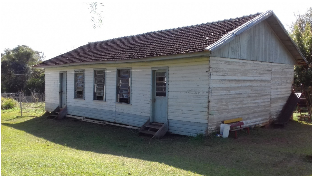
Figura 1. Escola Brizoleta, Distrito de Pinhalzinho. Parte Frontal (2018).
