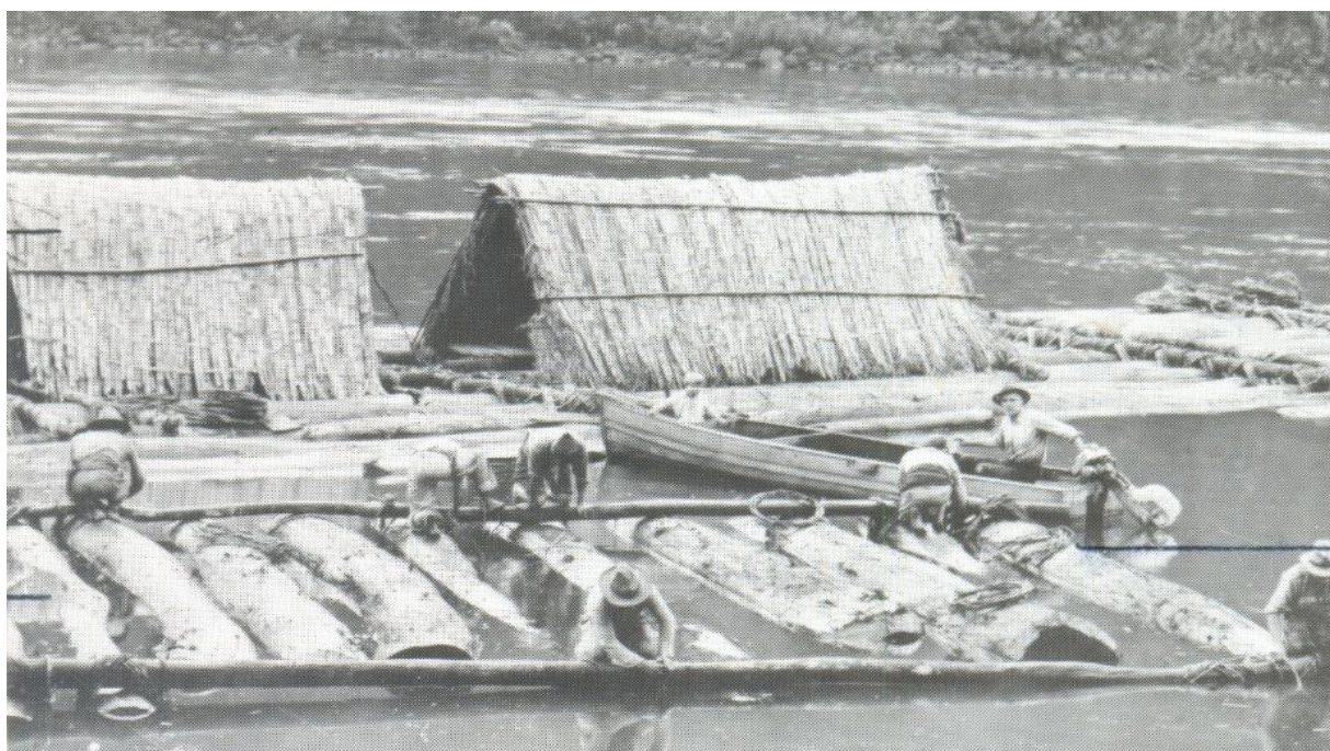
Fotografia 10: Montagem da balsa (1940)
