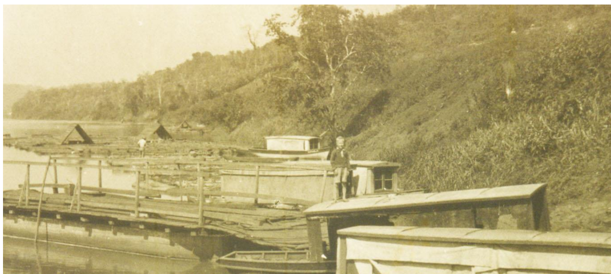
Fotografia 6: Na encosta do rio
