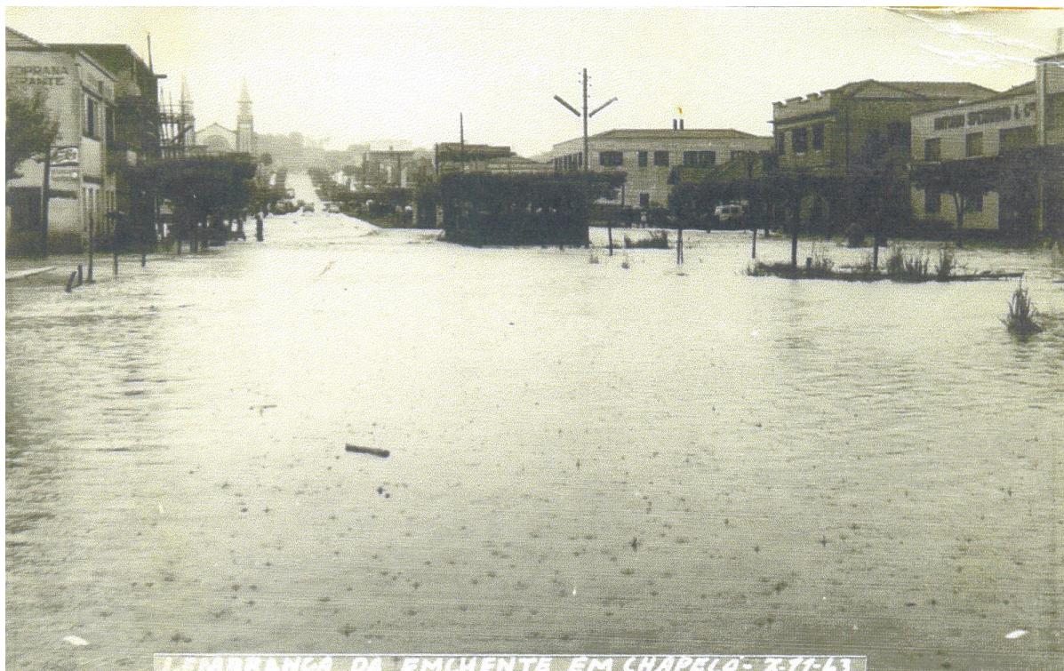
Fotografia 8: Enchente em Chapecó-SC (1963)
