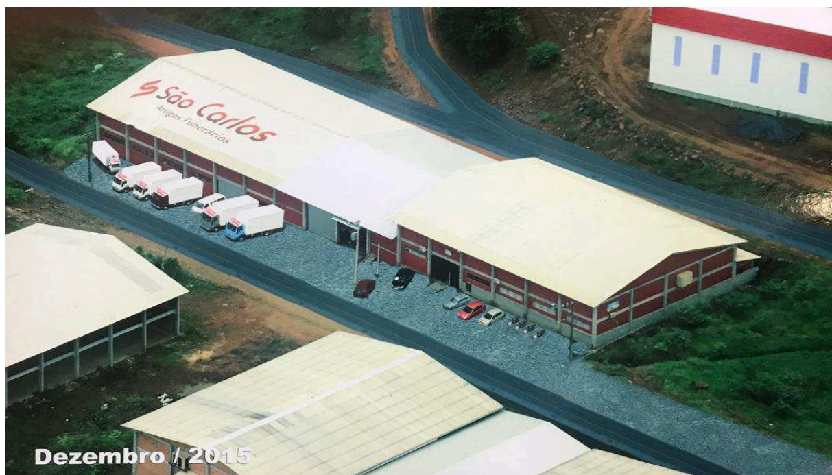
Figura 12 – Estrutura Externa da Empresa
