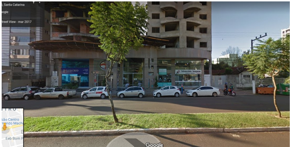
Figura 15 — Fachada do prédio
