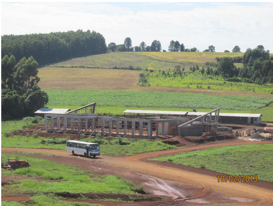
Figura 11 Construção da UFFS, 2012.
