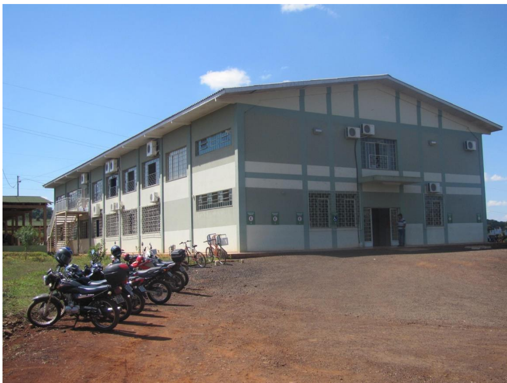
Figura 7 Chegada do primeiro prédio onde a UFFS funcionou, 2010.
