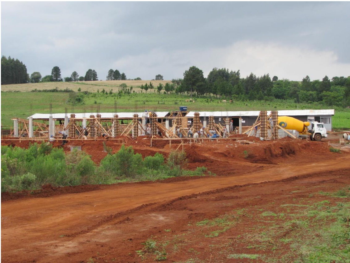
Figura 9 Construção da UFFS, 2012.
