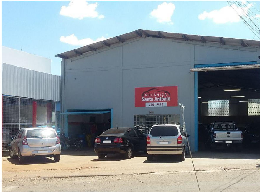
Figura 6 Barracão atual fachada externa
