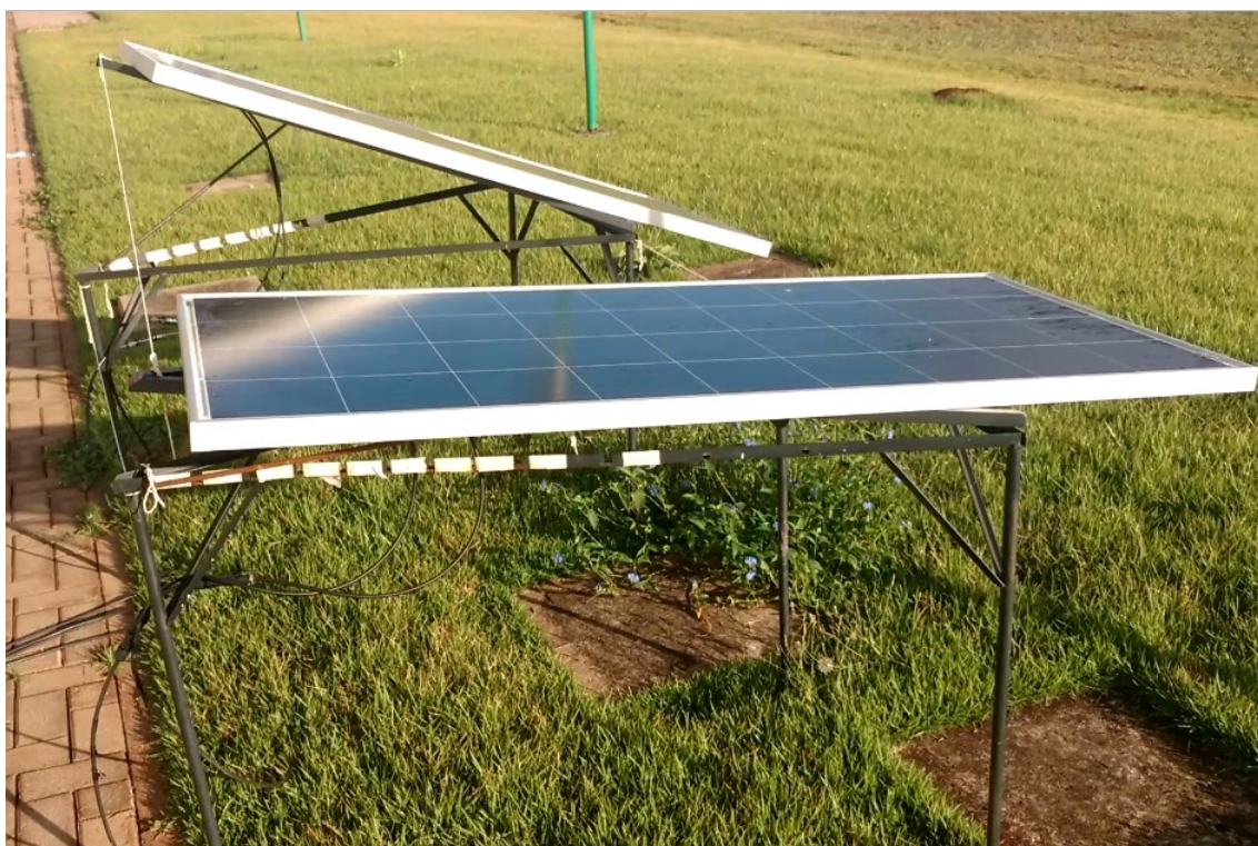
Figura 25 – Estrutura móvel para fixação das PV.
