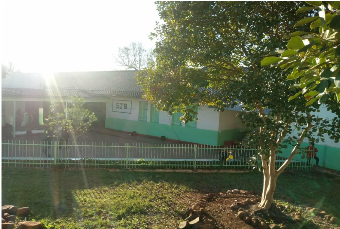
Figura 06 – Imagem da atual fachada da Escola SJB.
