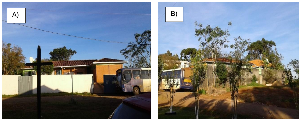
Figura 1 – Estrutura física do Colégio Estadual do Campo Professor Valmir Nunes, A) imagem da frente do colégio; B) imagem da lateral do colégio.
