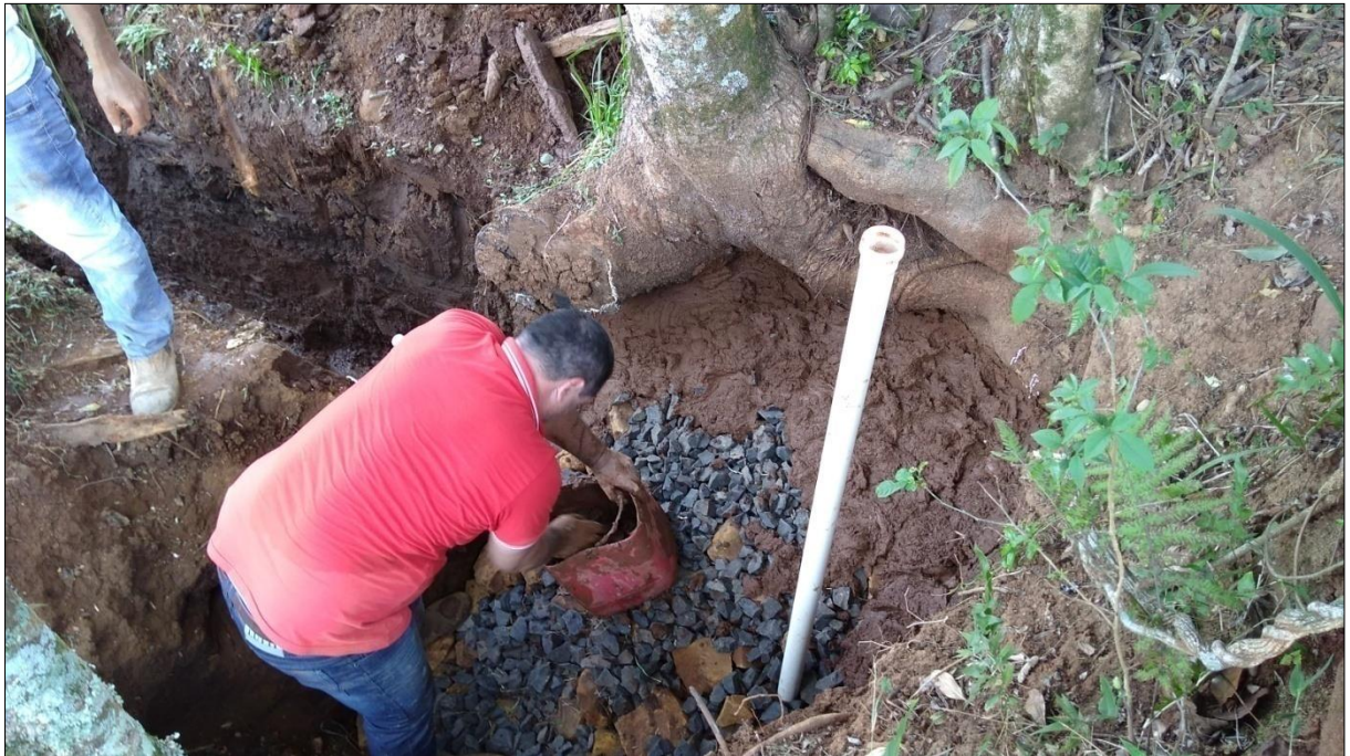
Imagem 15: Nascente sendo fechada com solo-cimento
