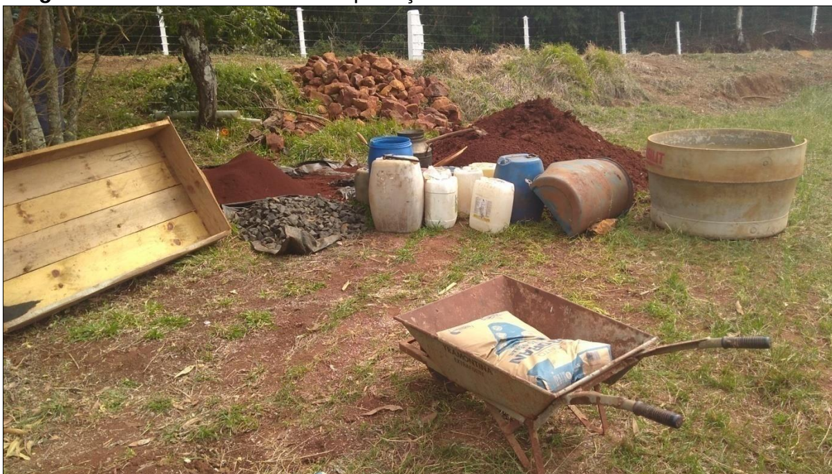
Imagem 10: Materiais utilizados na proteção da nascente
