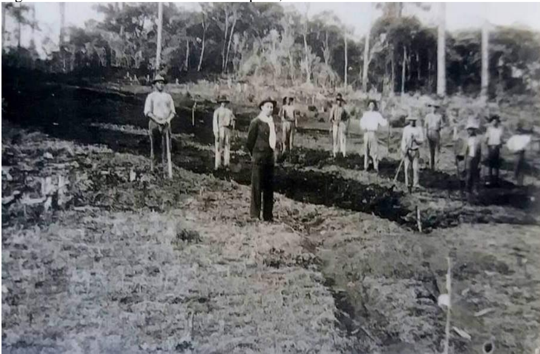
Figura 13: Abertura de Estrada em Chapecó, 1940.
