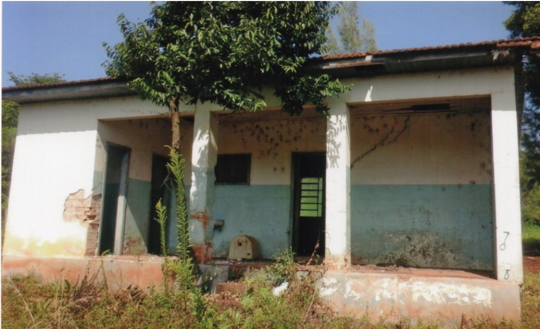
Figura 9 – Escola Municipal Carlos Chagas, na Comunidade de Nossa Senhora de Lurdes
