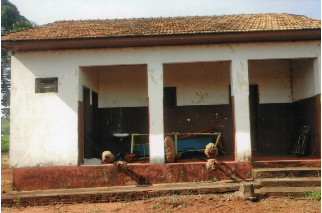
Figura 2 – Escola Municipal Olavo Bilac, na comunidade de Cachoeira Alta
