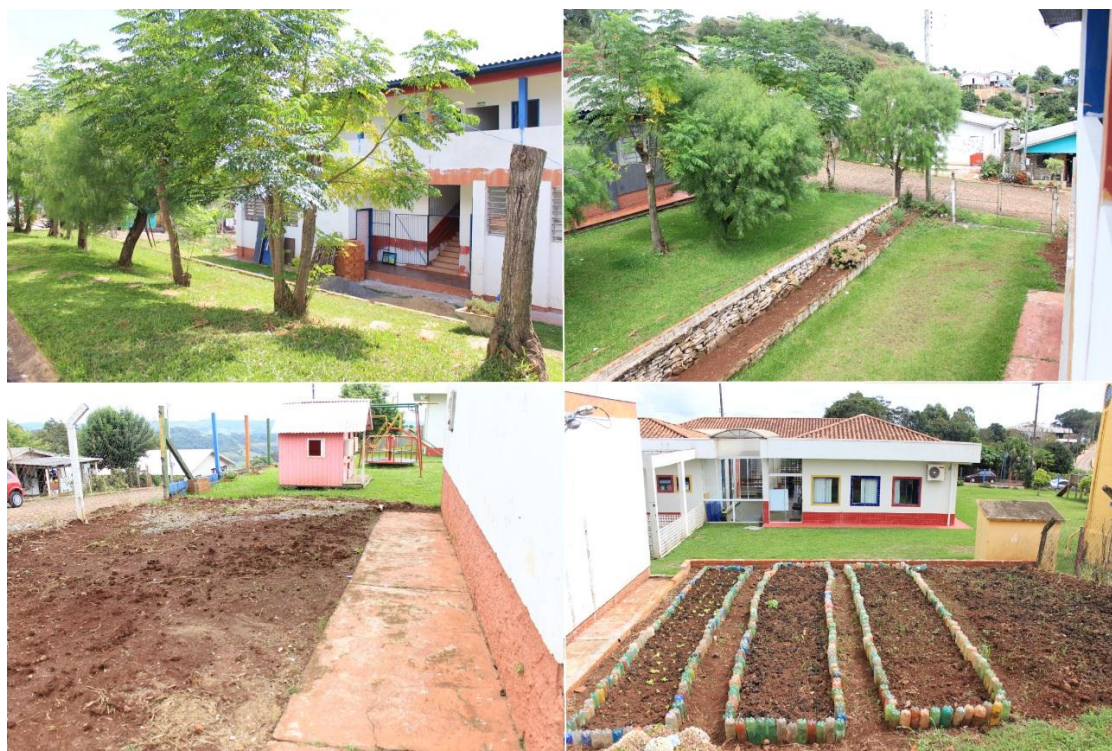
Fotografia 51 – Os espaços externos no entorno do novo edifício
