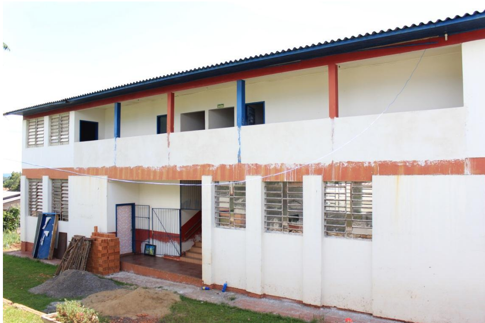
Fotografia 46 – Visão frontal do prédio que passou a ser utilizado em 2018
