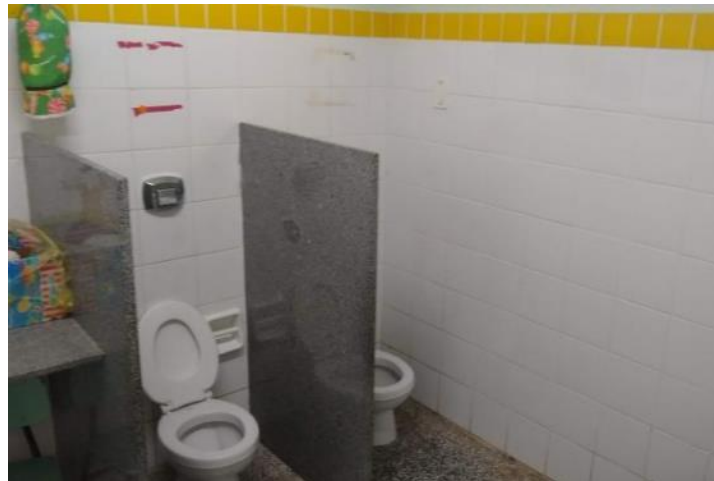
Figura 20 — Banheiro da sala do Maternal, Escola B. Disponibiliza sanitários e bancada para trocador de fraldas
