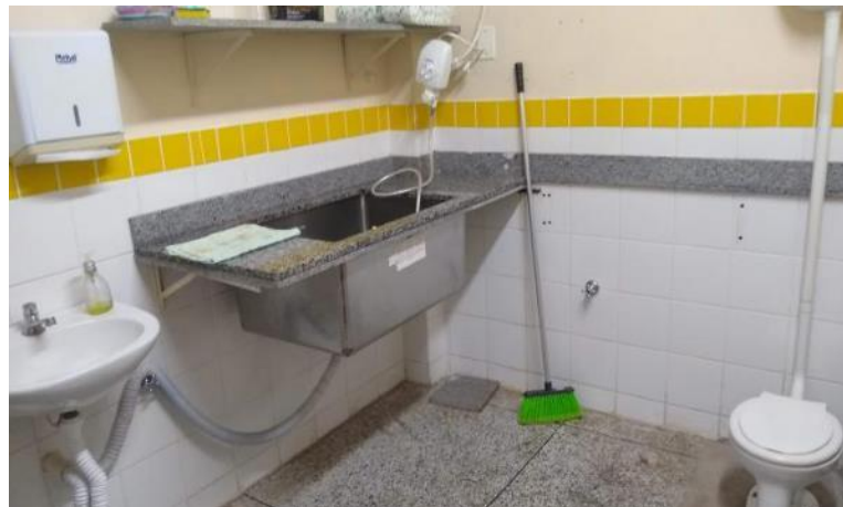
Figura 14 — Banheiro da sala do Berçário da Escola B
