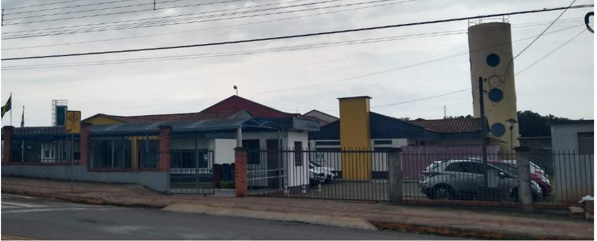
Figura 8 — Fachada da Escola B
