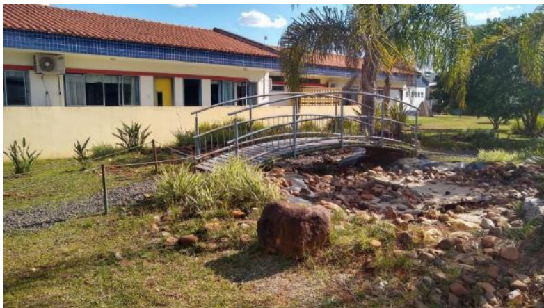
Figura 46 — Área externa, Escola B. Ponte onde havia lago
