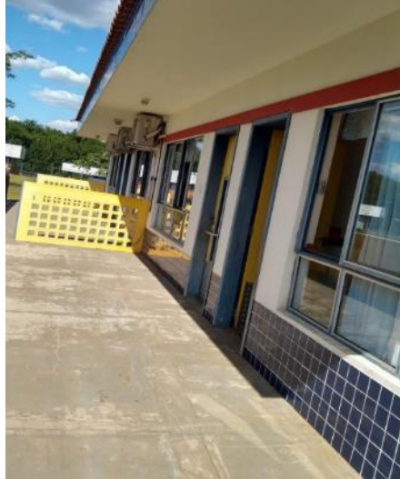
Figura 33 — Solários integrados às salas do Pré A e B, na Escola B
