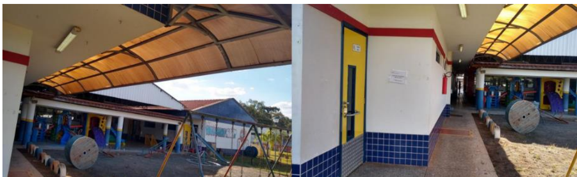
Figura 56 — Corredor de deslocamento com cobertura
