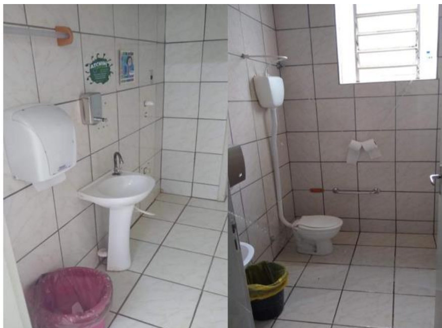
Figura 64 — Sanitário pavimento inferior, Escola A
