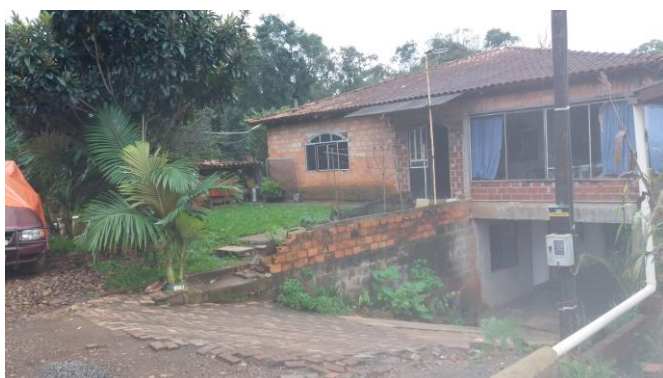
Fotografia 04 - Vista Frontal da residência da benzedeira Arruda
