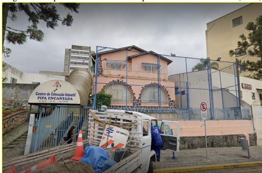
Figura 11- Pipa Encantada CEI - Hospital De Clínicas – UFPR (1989)
