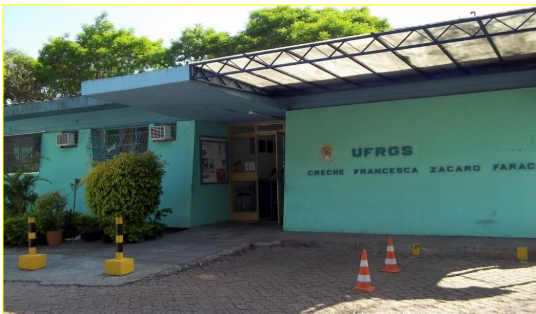
Figura 8- Fachada da Creche Francesca Zacaro Faraco- UFRGS (1972)
