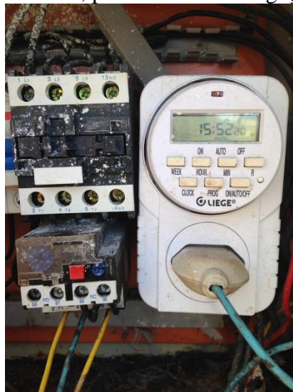
Figura 16 - Temporizador instalado, para sistema de irrigação, no viveiro experimental
