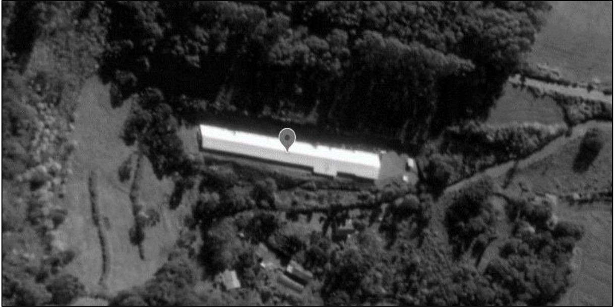
Figura 2 - Vista aérea do aviário.
