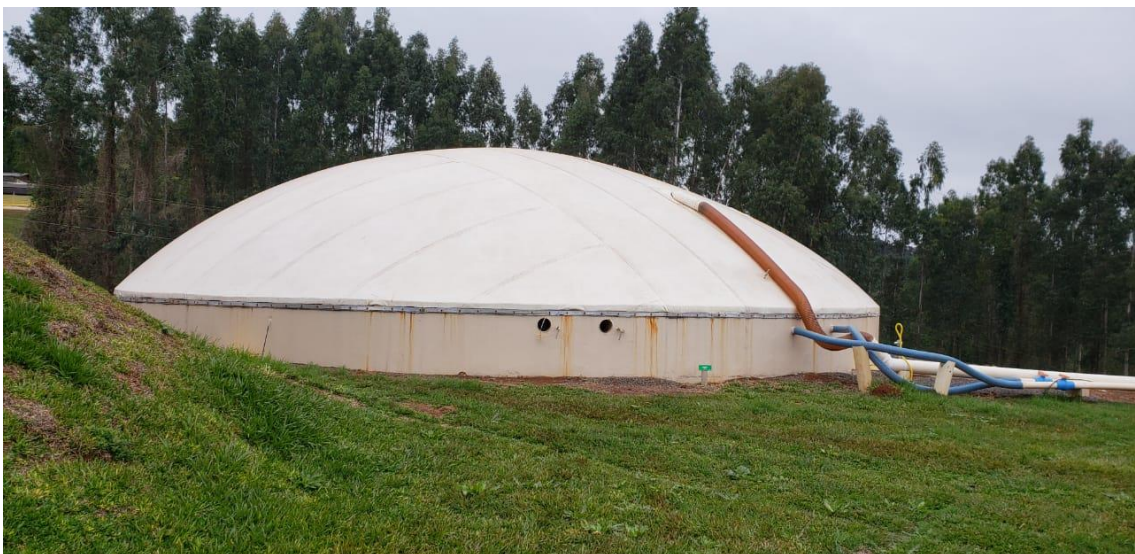
Figura 8 – Reator CSTR, que recebe fração sólida do dejetos previamente separado na etapa de SSL, do módulo Bio
