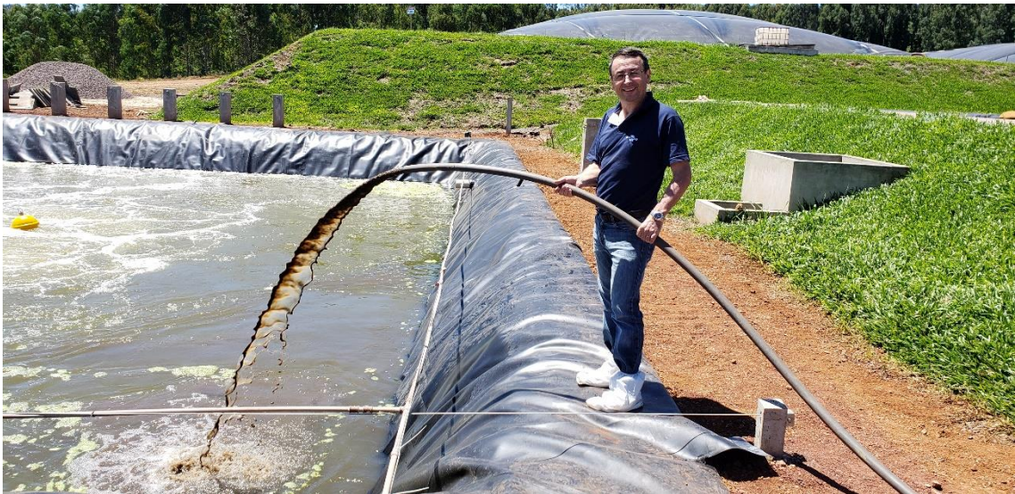
Figura 21 – Adição de 30 m 3 de lodo nitrificante para segunda partida de reator nitrificante
