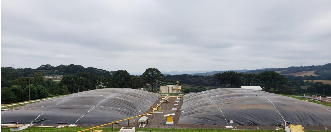
Figura 7 – Biodigestores de lagoa coberta, que recebem a fração líquida do dejetos previamente separado na etapa de SSL, do módulo Bio
