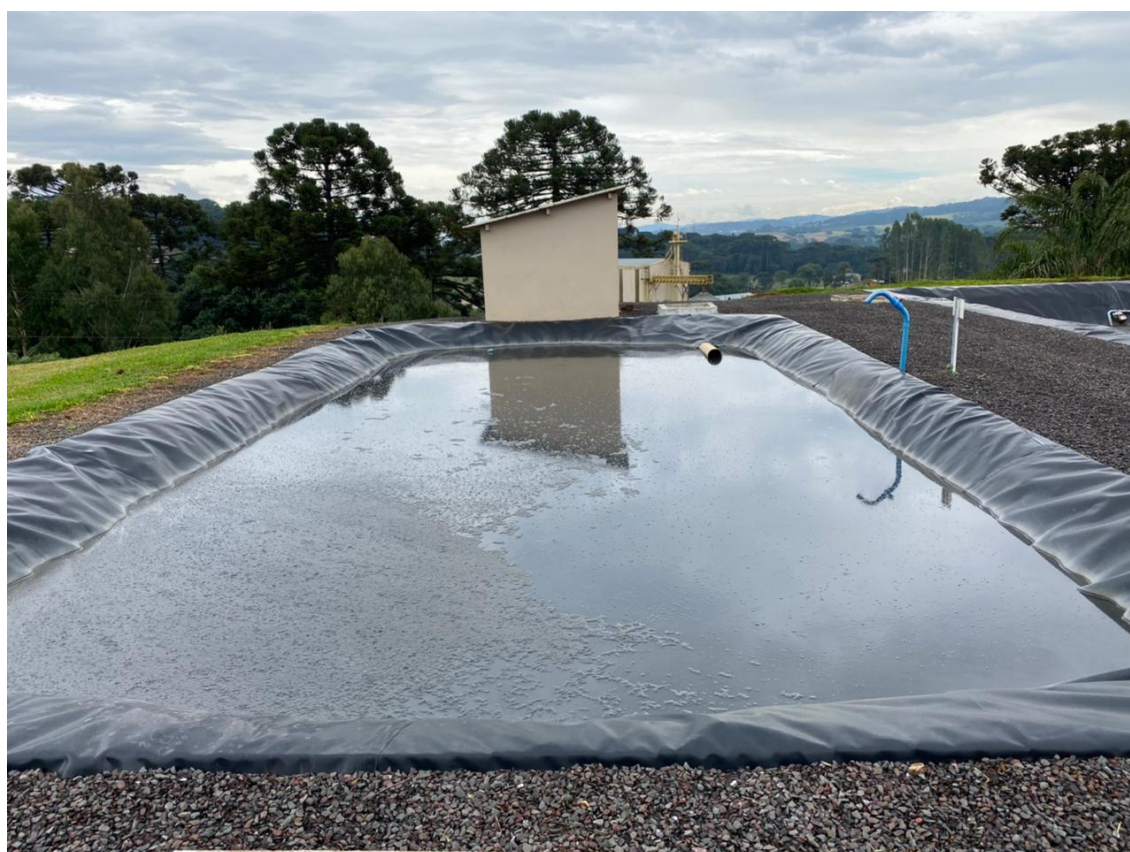
Figura 11 – Decantador 2, etapa que antecede a entrada do efluente no reator desnitrificante utilizado para controle de sólidos e nutrientes nos meses mais frios
