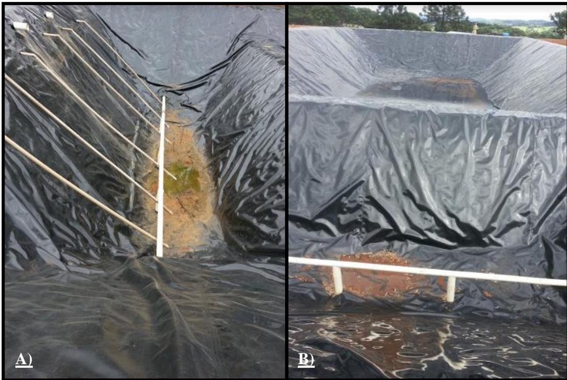
Figura 40 – BLCs em fase de construção, onde é possível visualizar um decantador secundário dentro do próprio biodigestor
