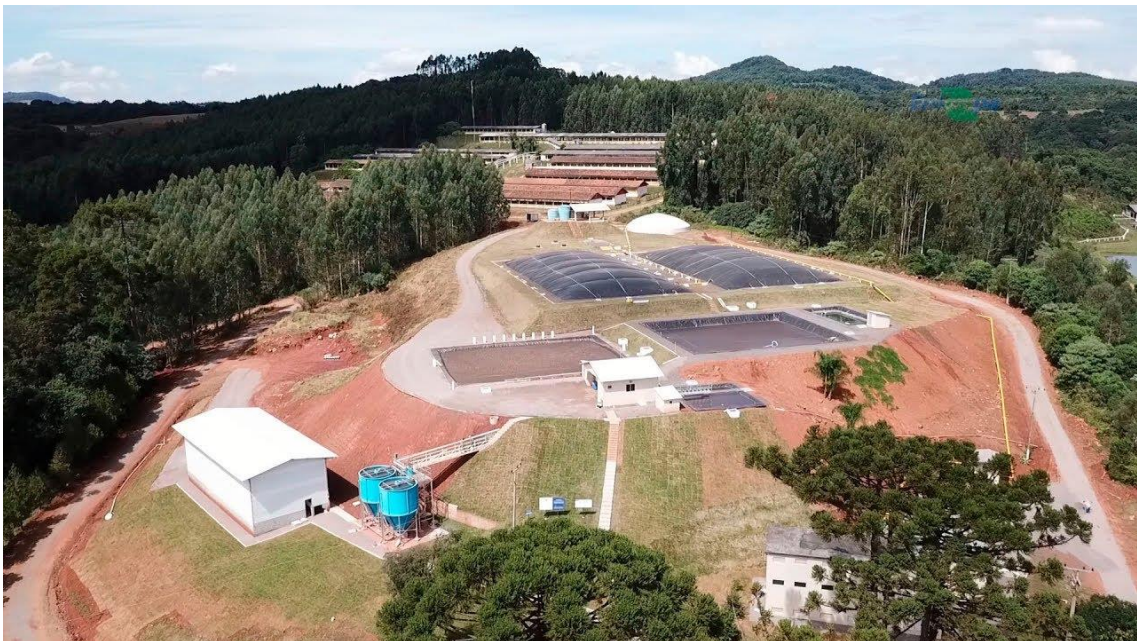
Figura 3 – Imagem aérea de Sistema de Tratamento de Efluente da Suinocultura – SISTRATES®, localizado na Granja São Roque em Videira – SC
