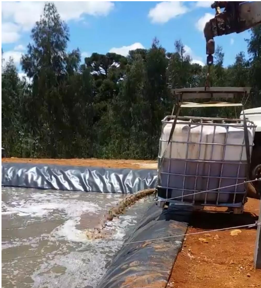
Figura 19 – Primeira inoculação de reator nitrificante com lodo aclimatado proveniente da Estação de Tratamento de Dejetos Suínos (ETDS) da Embrapa Suínos e Aves
