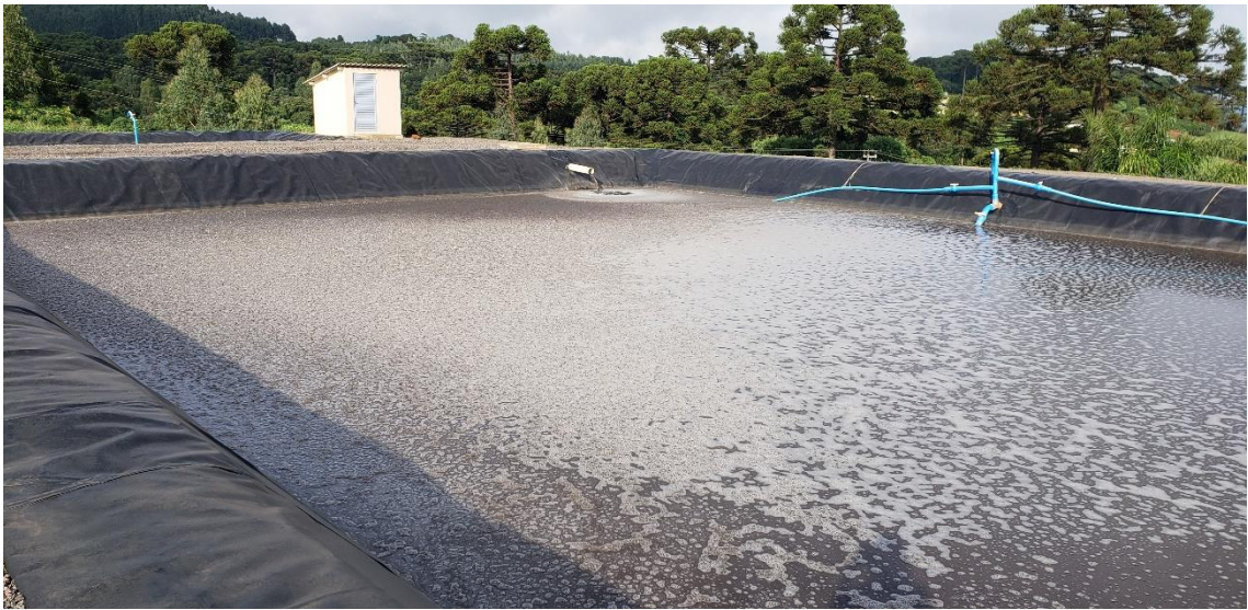
Figura 12 – Reator anóxico/desnitrificante, primeiro reator do Módulo N onde ocorre a conversão de nitrato a nitrogênio gasoso
