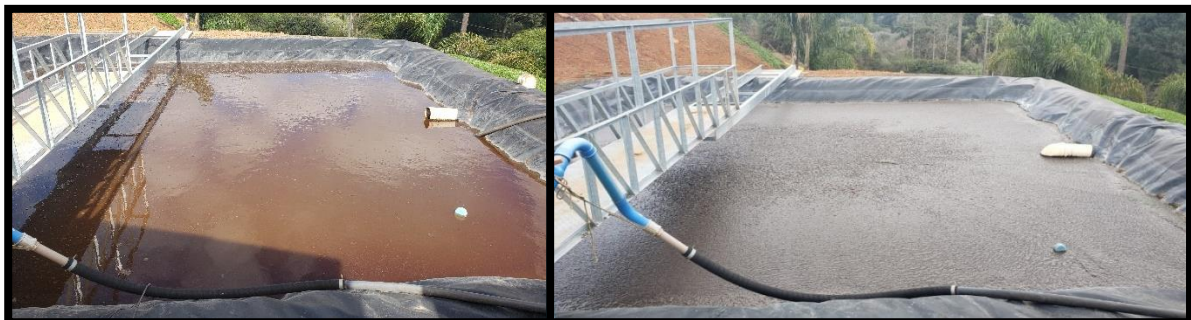
Figura 54 – Diferentes condições do Decantador 3, comparando o manejo de lodo adequado com a falta de manejo de lodo
