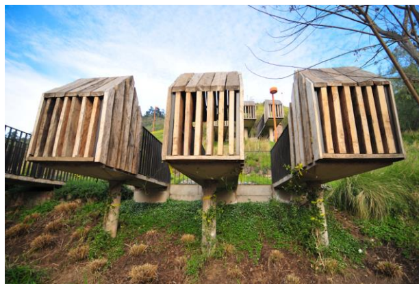
Figura 7: Acessibilidade e iluminação.
