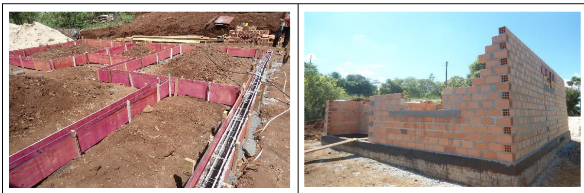
Figura 10 - Andamento das obras
