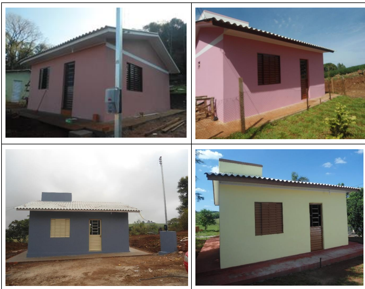
Figura 11 - Casas concluídas ou em fase de conclusão
