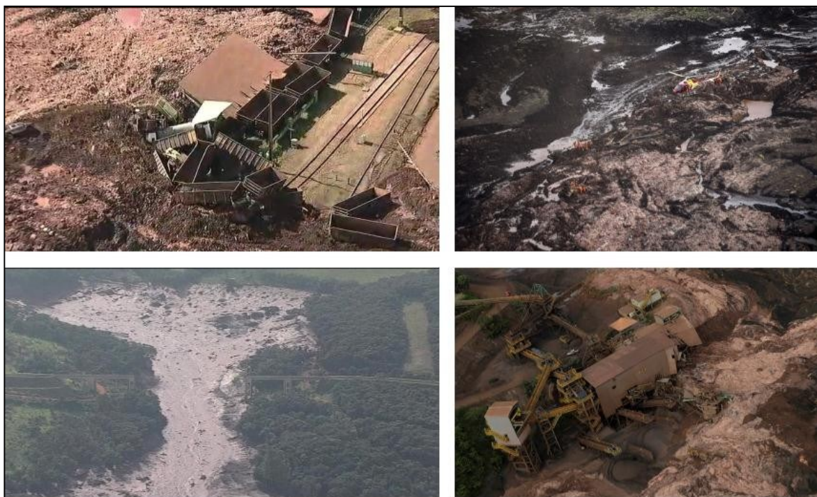
Imagem 1: Destruição causada pelo rompimento da Barragem I de Rejeitos da Mina de Córrego do Feijão
