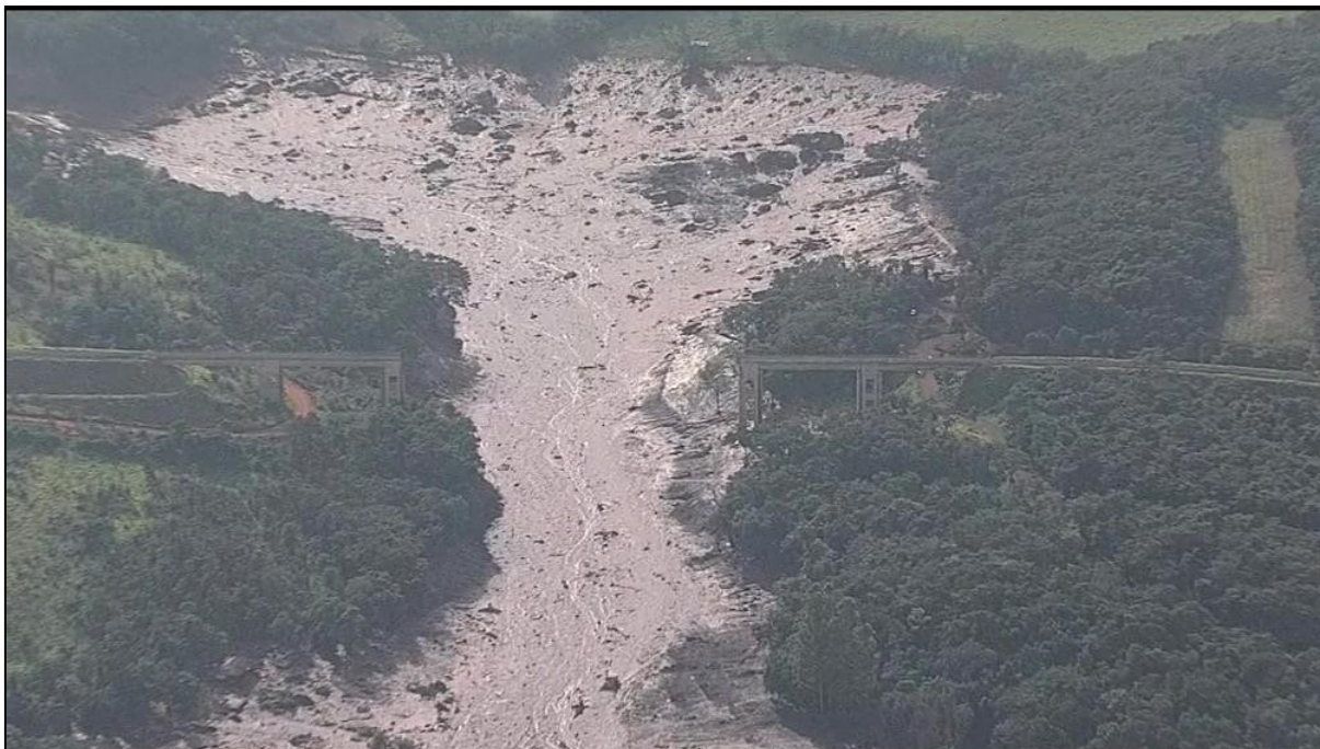
Imagem 12: Pontilhão destruído pelo rompimento da Barragem I da Mina de Córrego do Feijão
