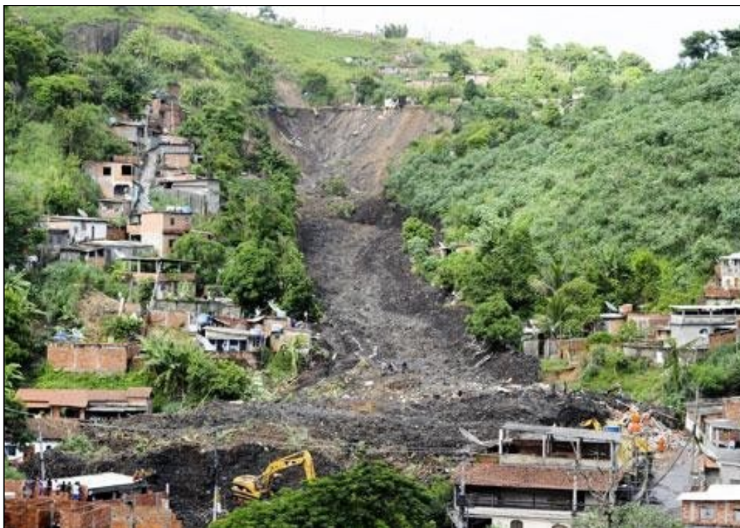
Imagem 2: Deslizamento de terra no Morro do Bumba, Niterói em 2010
